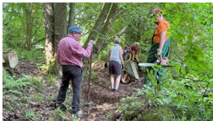
Der historische Wassergraben wird in einem Teilstück von Bewuchs, Altholz und Laub befreit (Foto: Gerhard Hosemann)
